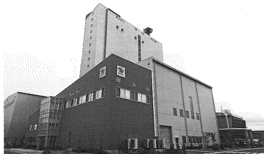
バイオマス発電所の外観。高い建物はボイラー部分
