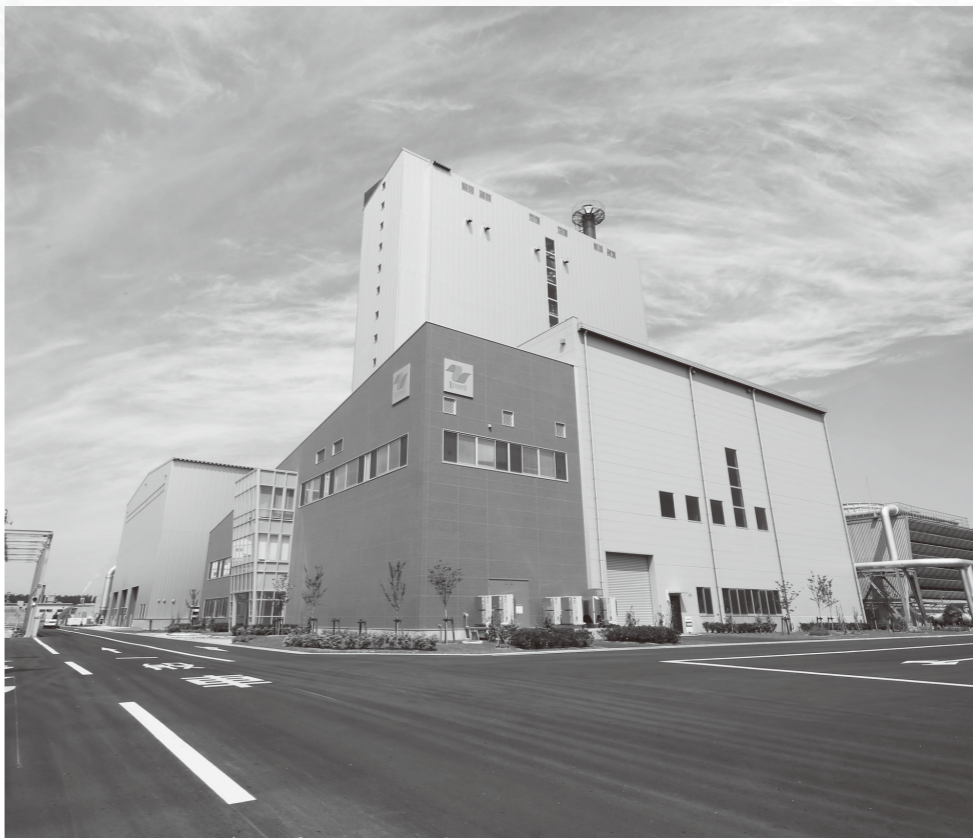
秋田市向浜に建設されている木質バイオマス発電所
